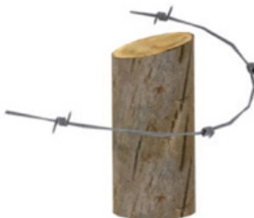
**16.** Coloque o rolo próximo ao mourão esticador, localize a ponta do arame farpado e solte aproximadamente 3 m de comprimento.
