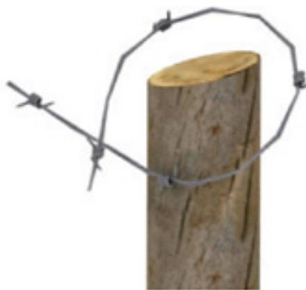
**25.** De um pouco mais de tensão no arame e ajuste o arame desenrolado envolta do mourão esticador.
